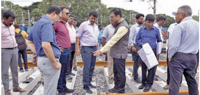
ట్రాక్ పనులను పరీశీలిస్తున్న జిఎం అరుణ్ కుమార్ జైన్ ఇతర అధికారులు
